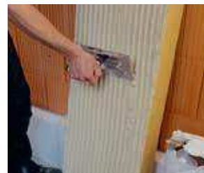
Coller l'isolant sur un support plat en appliquant une couche de mortier sur toute la surface du panneau
